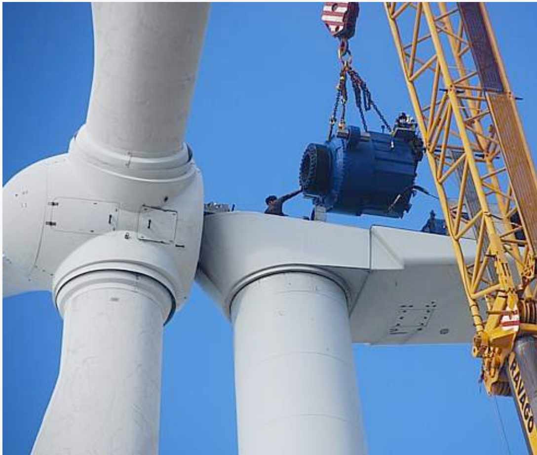
Fig. 16. Si los fallos en máquinas con ejes a bajas velocidades de giro no se detectan a tiempo las consecuencias de estos fallos pueden llegar a destruir completamente la máquina, como sucede en las multiplicadoras de los generadores eólicos. Aparte del coste de la multiplicadora se han de añadir los costes del reemplazamiento de esta en localizaciones donde la intervención para el reemplazo es también muy costosa.
